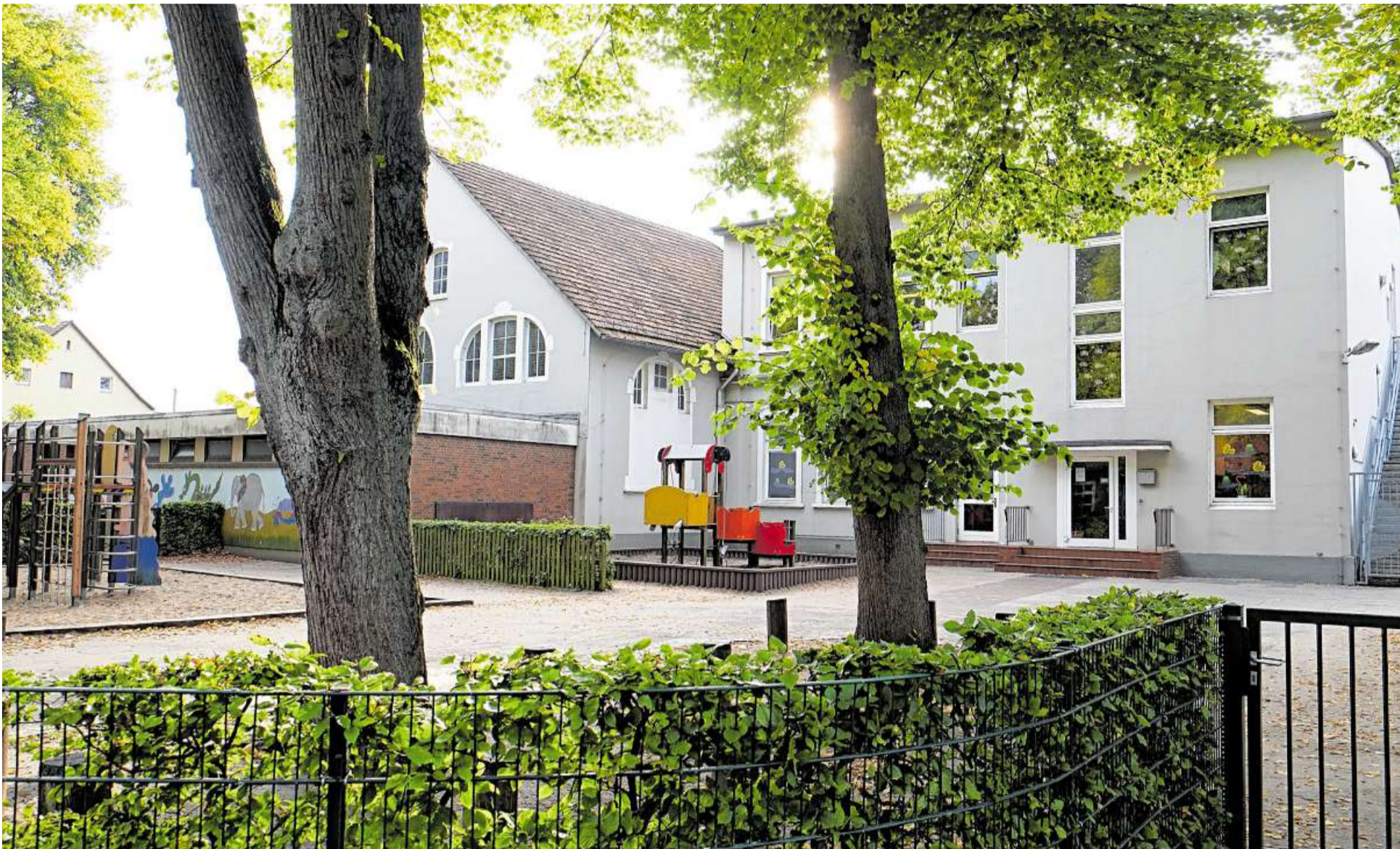
Die Awo-Kita an der Steding Straße ist eine der Einrichtungen, die eigentlich überholt sind und nur wegen des hohen Bedarfs noch weiter aktiv sind.
